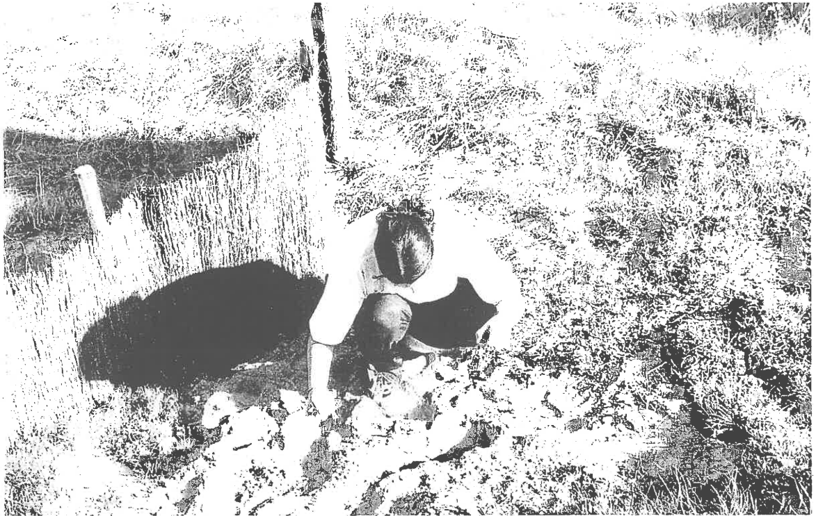
Colocamos pantallas para reter a area e frear a erosión.....
